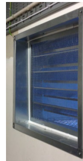
Bild 6: Jalusislutare efter montering
