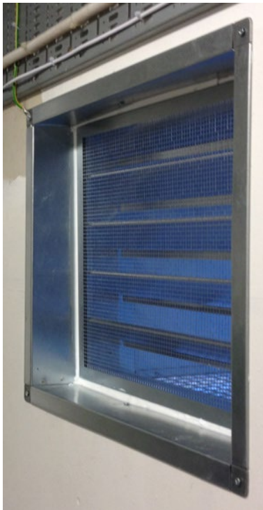
Bild 6: Jalusislutare efter montering
