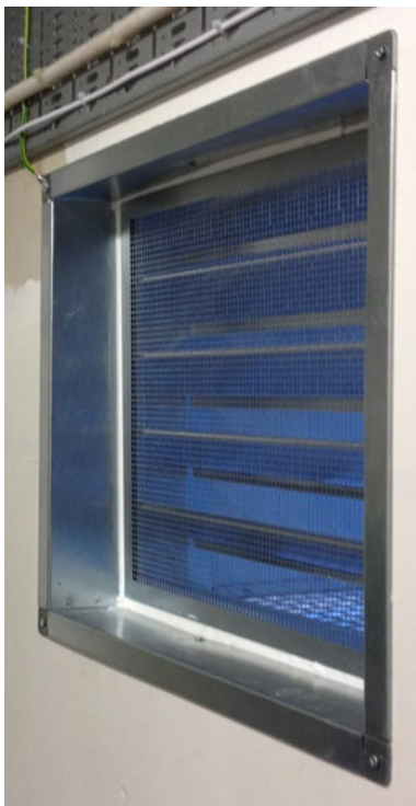
Bild 6: Jalusislutare efter montering
