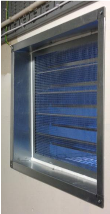
Bild 6: Jalusislutare efter montering
