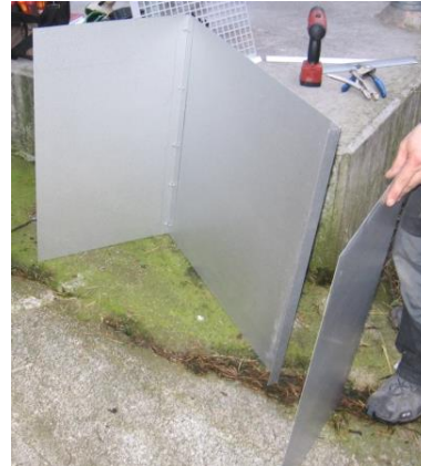
Popnita eller skruva fast plåtarna
