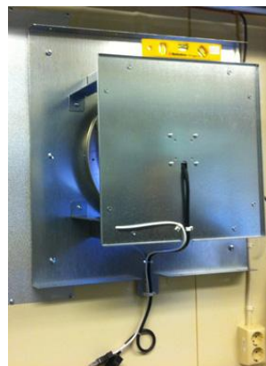
Bild 3: Anslutningsplåt med fläkt
