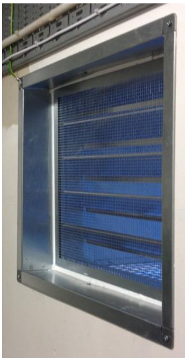
Bild 6: Jalusislutare efter montering
