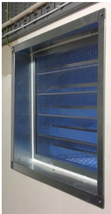
Bild 6: Jalusislutare efter montering
