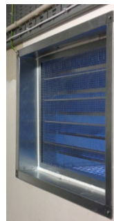
Bild 6: Jalouslutare efter montering
