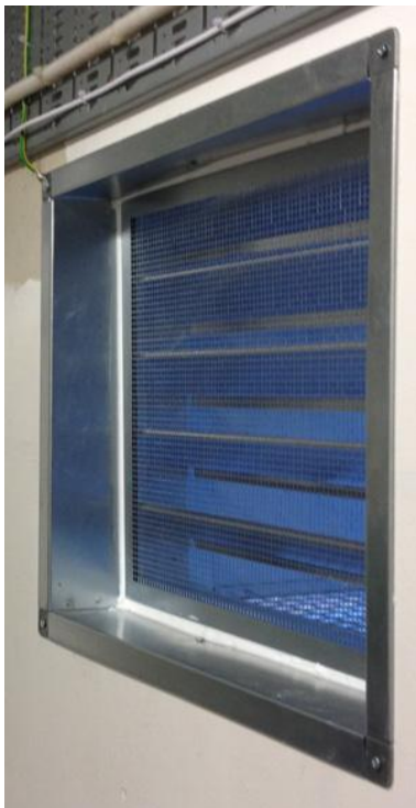
Bild 6: Jalusislutare efter montering
