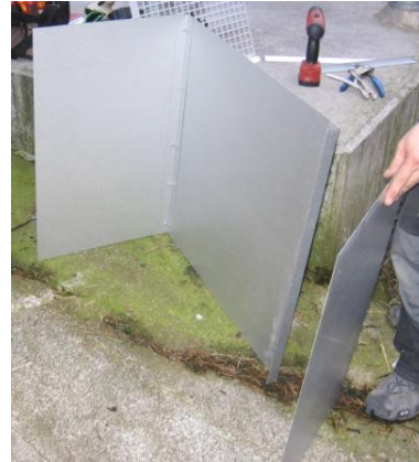
Popnita eller skruva fast plåtarna
