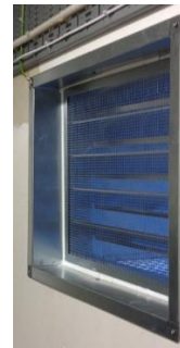
Bild 6: Jalouslutare efter montering
