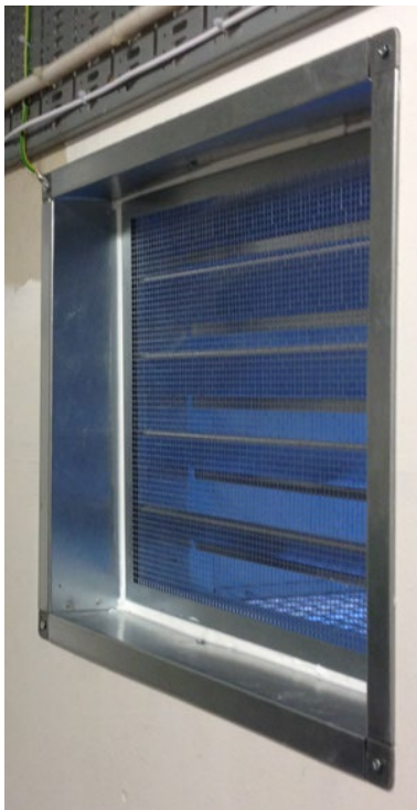
Bild 6: Jalusislutare efter montering
